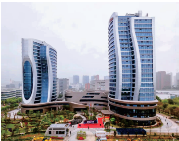
星网锐捷科技园基地三期建设项目
